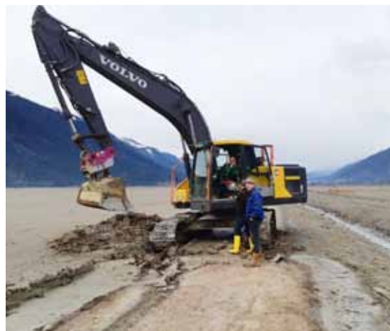
Aufräumarbeiten nach den Hochwasserschäden im Dezember 2018 in Rattendorf im Gailtal
