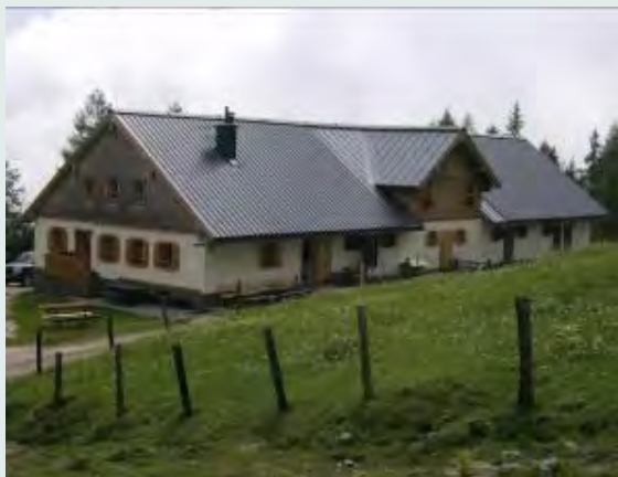
Abbildung 93: Das 1930 erbaute Almgebäude auf der Unteralm S2 wurde 2007 generalsaniert (Foto: Almobmann)
