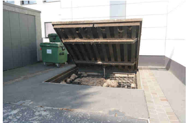
Brennstoffbunker
