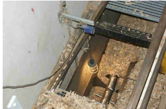
Brennstoffzufuhr
