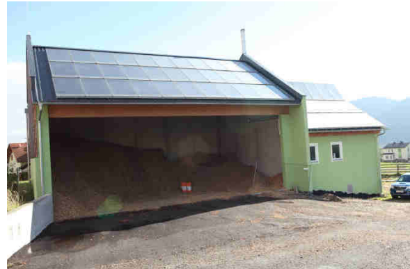
Brennstofflager mit Solarthermieanlage
