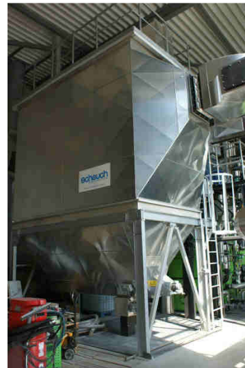
Elektrofilter
