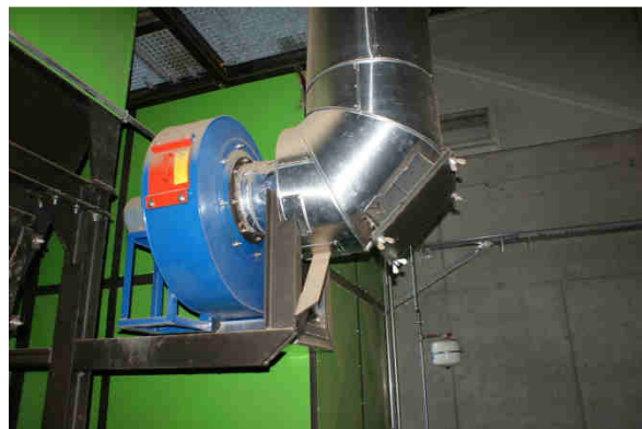
Verbrennungsluftventilator
