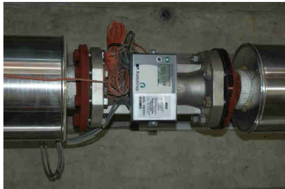
Wärmemengenzähler
