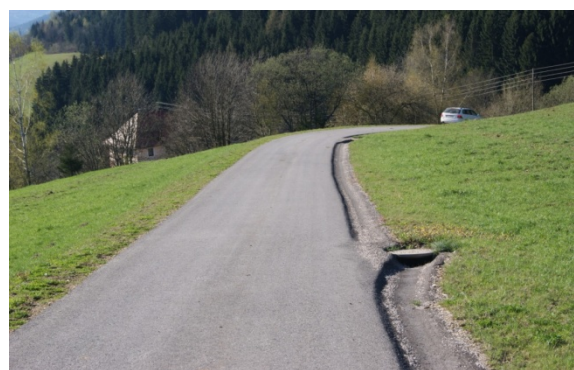
Nach Realisierung des Projektes: Asphaltfahrbahn mit Oberflächenentwässerung
