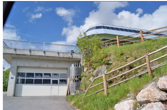
Mittelstation Seilbahn, direkt am Weg
