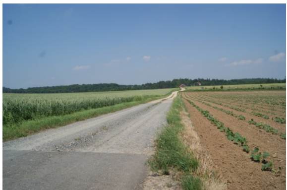
Asphaltbelag im Bereich der Einmündung in die Landesstraße
