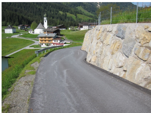
Leitschiene und Ausweiche erhöhen Sicherheit
