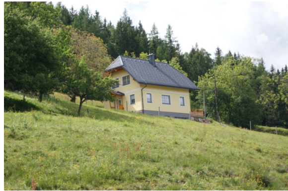
Jüngst thermisch sanierter, nicht-landwirtschaftlicher Hauptwohnsitz
