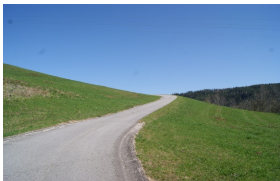
Nach Realisierung des Projektes: Asphaltfahrbahn mit Oberflächenentwässerung
