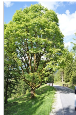
Zur Erhaltung dieses Bergahorns wurde die Trasse im Zuge der Bauarbeiten geringfügig verlegt
