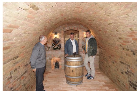
Innenansicht renovierter Keller
