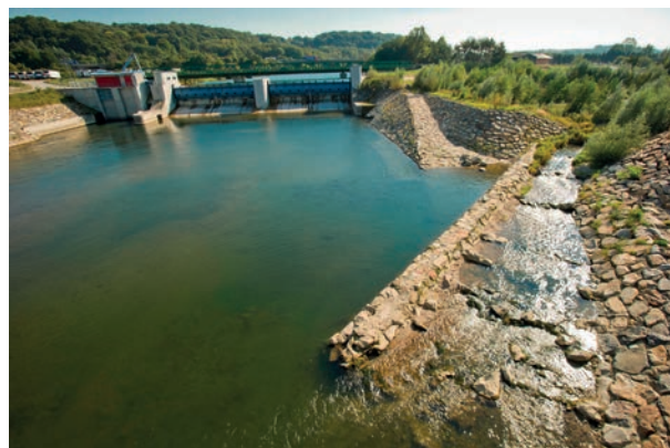
Wasserkraftwerk in Kimmelbach; rechts naturnaher Beckenpass
