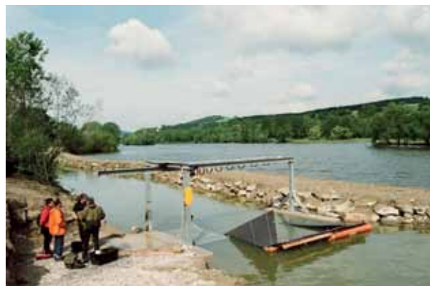
Fischaufstiegshilfe beim Kraftwerk Melk - Funktionskontrolle
