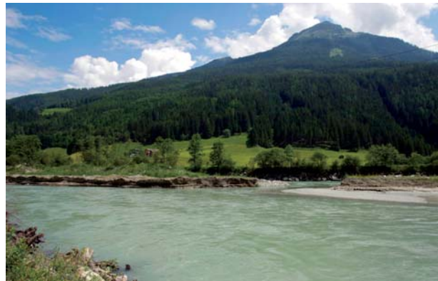
Hochwasserschutz Salzach Bramberg
