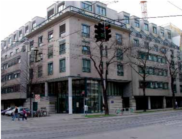
2010 wurden von der AMA wieder ca. 1,8 Mrd. Euro an öffentlichen Mitteln an 139.000 FörderwerberInnen ausbezahlt; Bild: AMA-Gebäude im 20. Bezirk in Wien.
