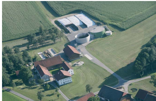
Biogasanlage in Mehrnbach, Oberösterreich, Agrar Portal
