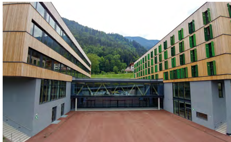
HBLFA Tirol: Mit der geplanten Fertigstellung des neuen Gebäudes in Rotholz im Herbst 2020 sind der Schulbereich und der Forschungsbereich räumlich unter einem Dach vereint.
