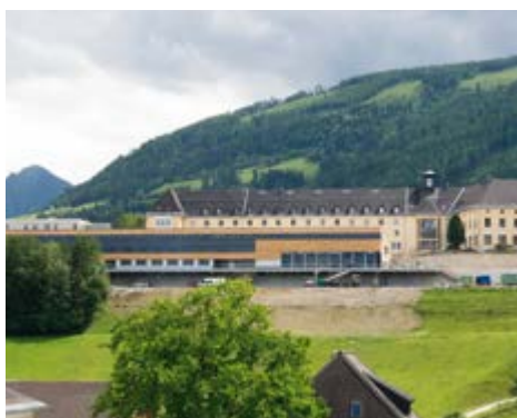
Der Neubau des Internats in Raumberg-Gumpenstein mit 114 Internatsplätzen und einer Doppelturnhalle wurde im August 2016 fertiggestellt.
