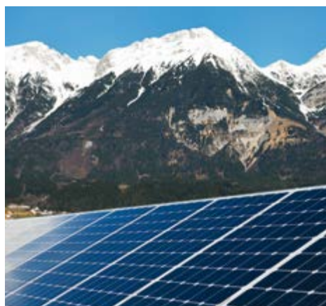
Seit 2010 ist ein deutlicher Anstieg der Leistung aus Photovoltaikanlagen erkennbar. Mit 590 MW machten diese 2014 etwa 2,4 % des österreichischen Kraftwerksparks aus.
