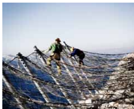
Der Lawinenschutz ist eine unverzichtbare Maßnahme zur Absicherung von Dauersiedlungsgebieten. Foto: Hohe Munde, Tirol.
