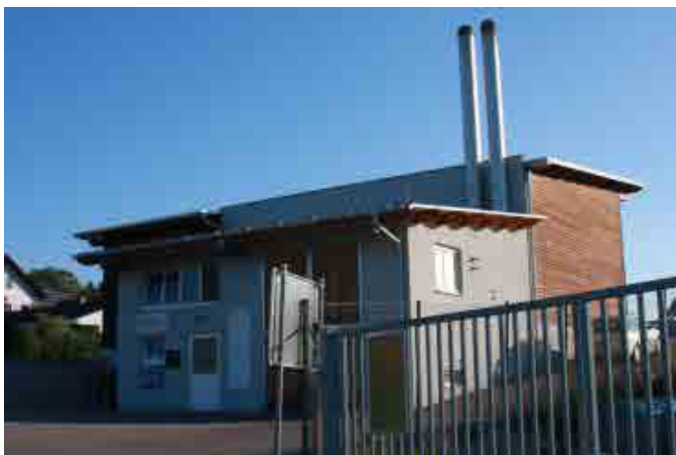
Biomasse-Nahwärmanlage Maria Laach/Jauerling; Copyright: Josef Petschko
